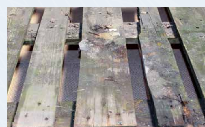
Trocknung/Reinigung durchnässter Bretter
