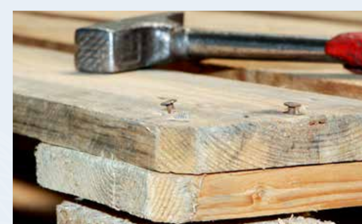
Einschlagen herausstehender Befestigungselemente
